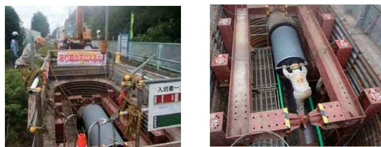
\*パイプ・イン・パイプ工法…老朽化した既設管の中に新設管を挿入していく工法です。
