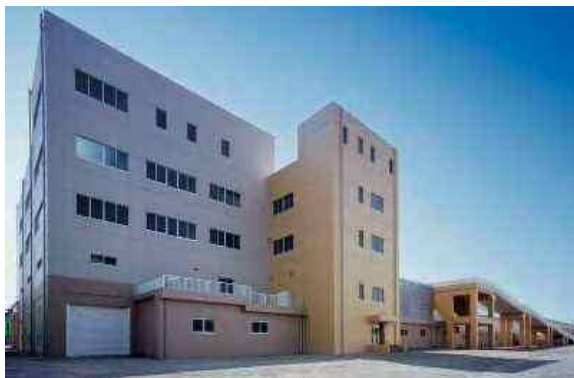
入江崎水処理センター西系施設
