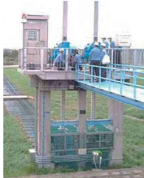
排水樋管ゲート操作訓練
