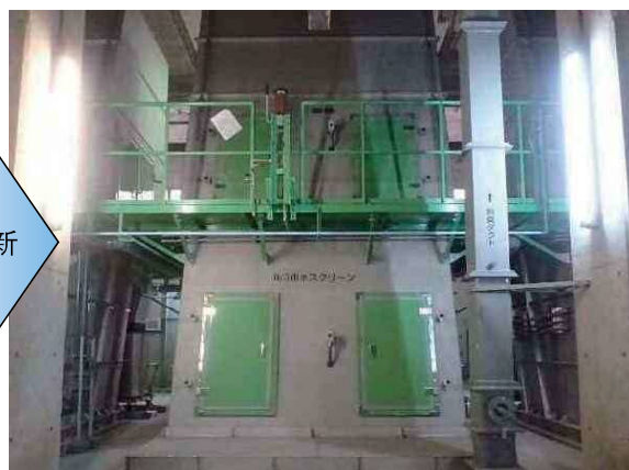
老朽化したスクリーン設備の更新
