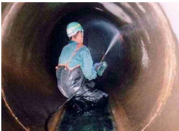
管きよの清掃状況
