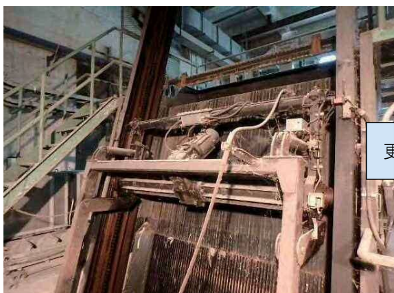
老朽化したスクリーン設備の更新
