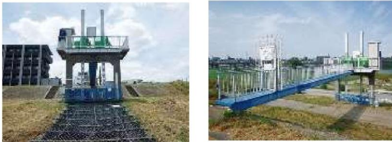
排水樋管ゲートの改良
