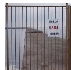
〔東扇島波除堤〕
