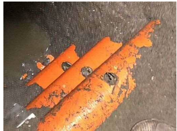
写真 3.2 破損状況 (拡大)
