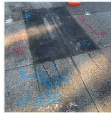
ペンキ等による目印状況
