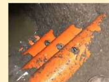
破損状況(拡大)
