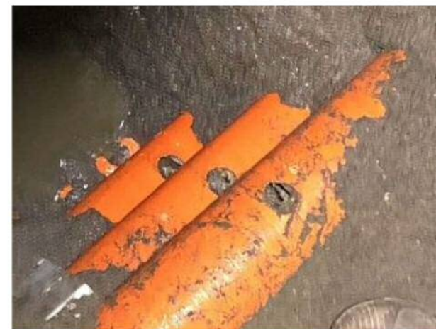
写真-1 破損状況(拡大)
