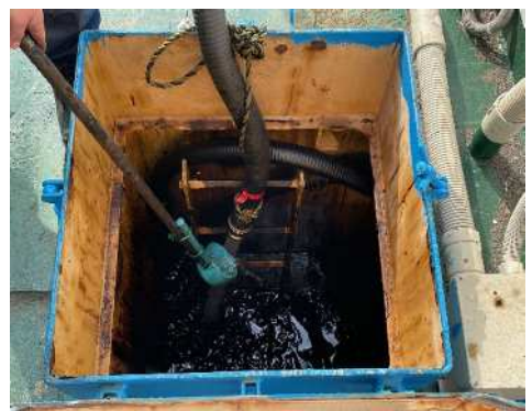
ビルジ等をタンクへ移す様子
