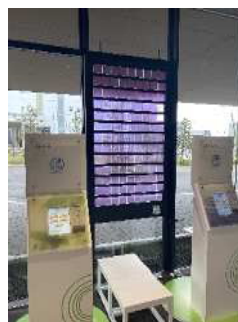
オフィスの空調の省エネに貢献する調光ガラス開発 【左：設置した調光ガラス、右：調光ガラスの特徴】
