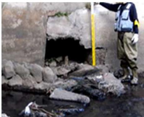
図 3.20 老朽化による護岸背面の空洞
