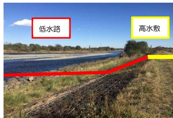
図 14.17 多摩川の高水敷と低水路
