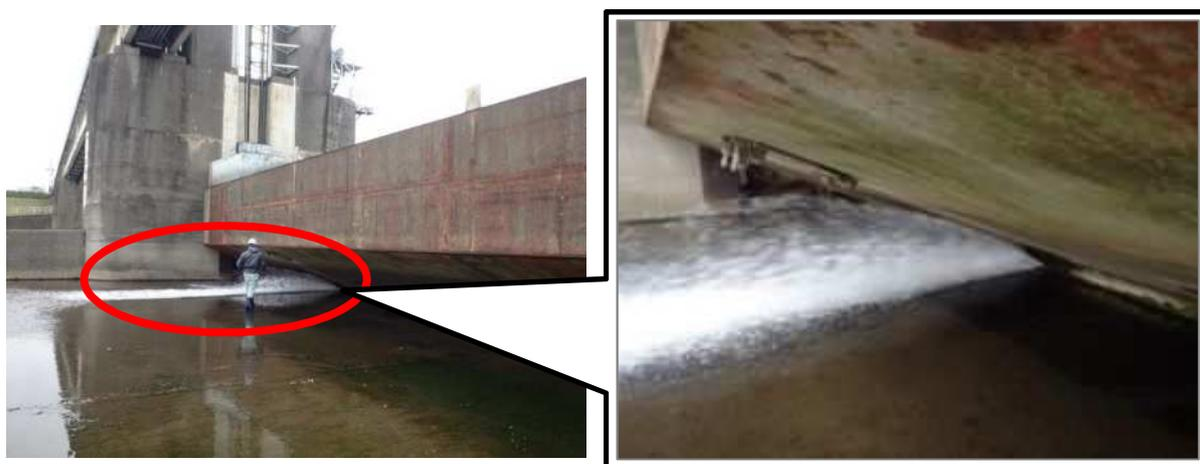
図 3.23 機械電気設備の劣化状況(上河原堰堤の扉体部分における水密不良)
