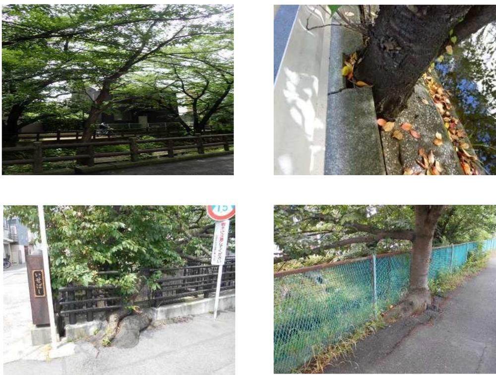
図 3.24 河川樹木が河川管理施設等を損傷させている様子
