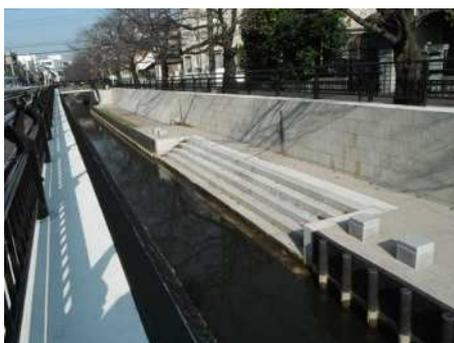
図 6.11 渋川環境整備工事における階段工
