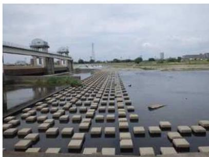
図 14.26 上河原堰堤の床止め(多摩区)
