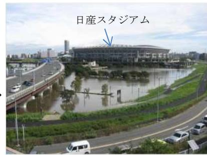
図 14.16 鶴見川多目的遊水地の洪水調節時（横浜市）
