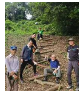
伐採木を活用した階段整備
