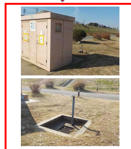
下流（トイレ・水飲み場）
