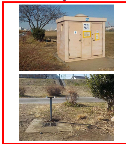
上流（トイレ・水飲み場）
