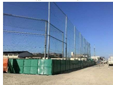
工事ヤード復旧工
