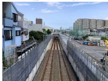
浸水防止壁設置工
