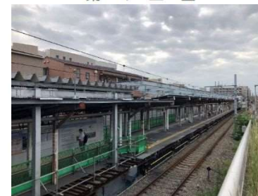
上家架設工(小島新田駅)
