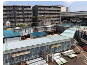
構内通路設置工(大師橋駅)
