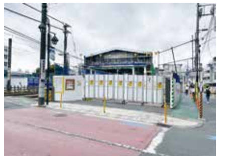
J R 稲田堤駅改築工事の様子
