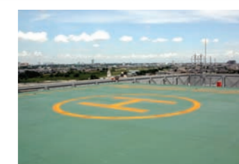
●屋上ヘリポート
