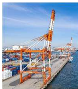
荷役機械 (ガントリークレーン)
