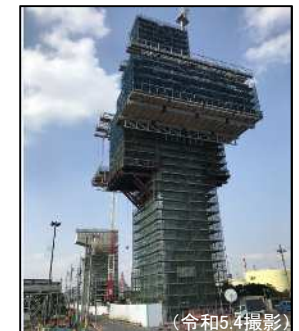
③ 橋脚MP5,6
