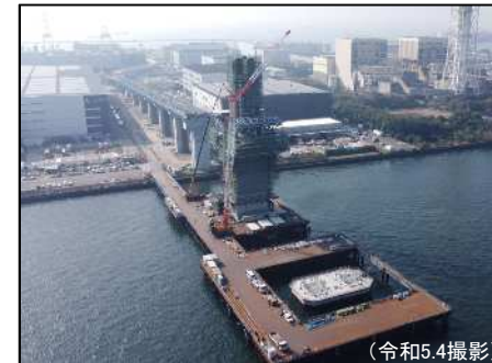
② 主橋梁部MP1～MP3
