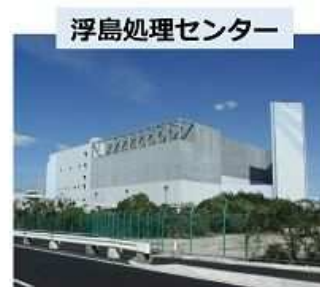
H7年10月竣工
