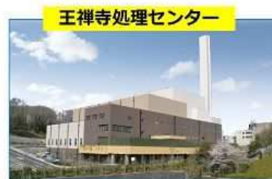
H24年3月竣工
