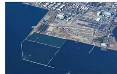
浮島 2 期廃棄物埋立処分場
