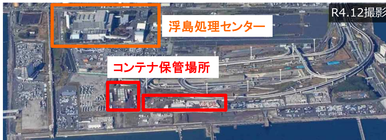
写真1 コンテナ保管場所の位置(浮島地区)
