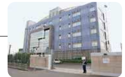
ターミナル入口 管理棟 Terminal entrance and office building
