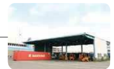
全天候型検査場 All-weather inspection Areas
