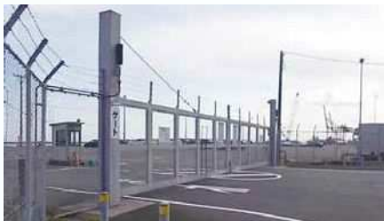
フェンスとゲート (東扇島外貿埠頭)
