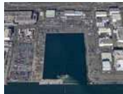
東扇島堀込部（R4年12月撮影） Excavated part of Higashi-Ogishima (Photo taken in Dec. 2022) 东扇岛堀込部（摄于2022年12月）
