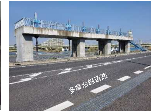
写真⑤: 放流樋門ゲート
