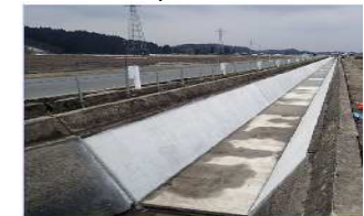
参照 柔性モルタルライニング工法
