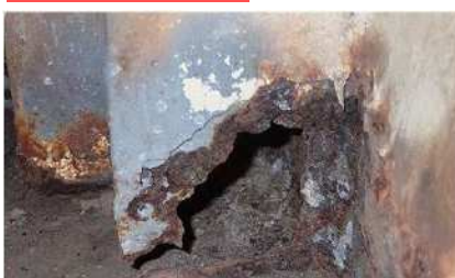
腐食部の補修補強
