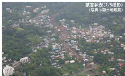
熱海市 土石流災害 発生状況 (国交省資料から)
