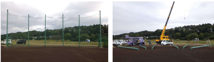
撤去作業前 → 撤去作業後
