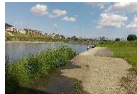
(第1広場川寄り・新設護岸周辺)
