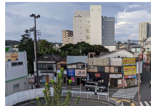
区画整理事業工事着手前（令和2年9月）
