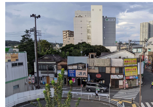
区画整理事業工事着手前（令和2年9月）
