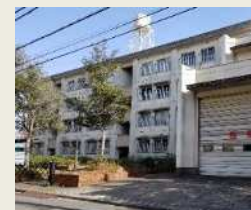
〈消防小田公舎〉
