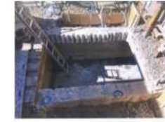
コンクリート支障物
