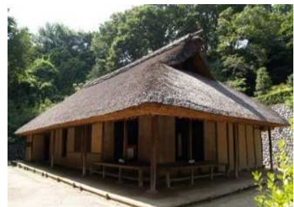
国指定重要文化財 旧伊藤家住宅（日本民家園）
