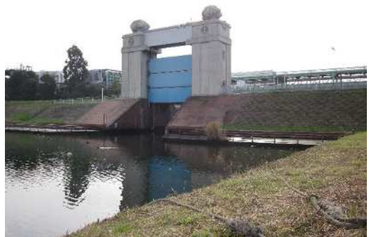
川崎河港水門
