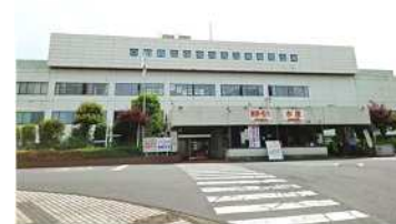
北部市場北門・管理事務所棟
