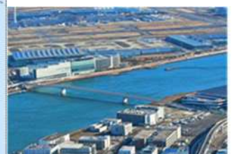
多摩川スカイブリッジ
