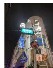
街路灯のLED化 (鹿島田商店会)
