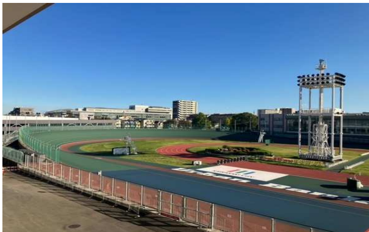
改修後のバンク
