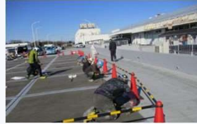
大規模屋上防水工事の様子
