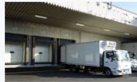
事業者が整備した低温管理設備
