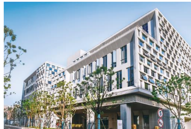
中国開発センター (RDC)
