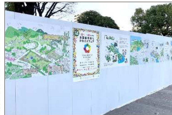
工事中の仮囲いを活用したPR 稲毛公園
