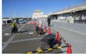
大規模屋上防水工事の様子
