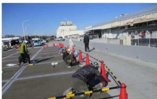
R3 関連商品売場棟屋上防水工事の様子
