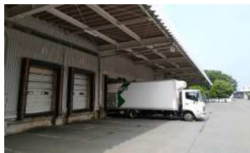
コンテナ全体を覆う大型庇
