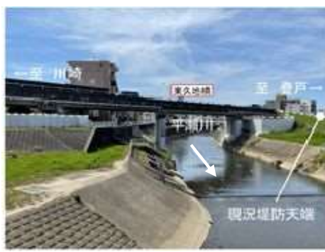
平瀬川との合流部（東久地橋付近）
