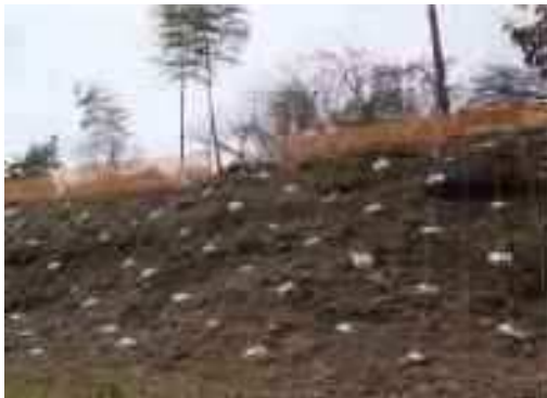
斜面安定整備工事 (生田榎戸特別緑地保全地区)
