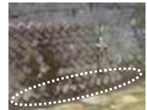
護岸の変状(ブロック隙間の拡大)
