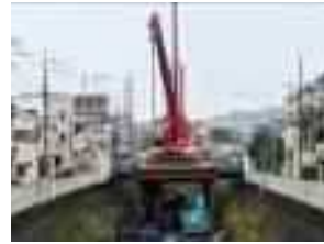
仮設構台の築造
