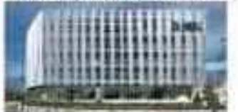
産学交流・研究開発施設 (10,000㎡) (建設中)
