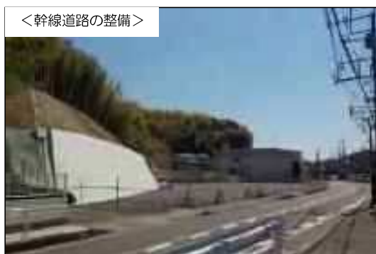
尻手黒川線（Ⅳ期）【擁壁施工中】
