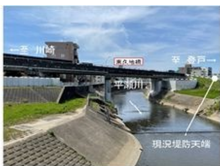
平瀬川との合流部（東久地橋付近）
