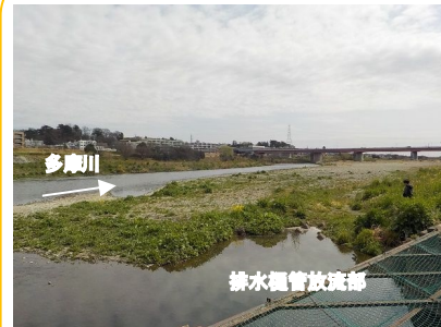
排水樋管放流部
