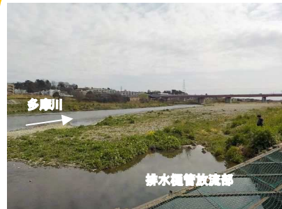
排水樋管放流部
