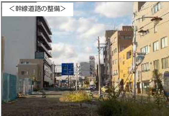
一般国道 409 号（小杉）【整備前】
