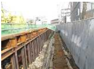
鋼管杭の打設
