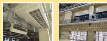
災害時にも利用可能な学校体育館の空調整備
