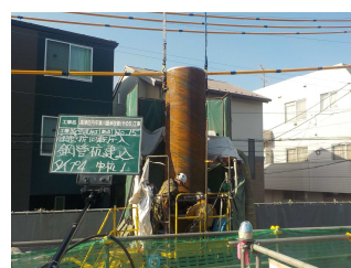
鋼管杭の打設
