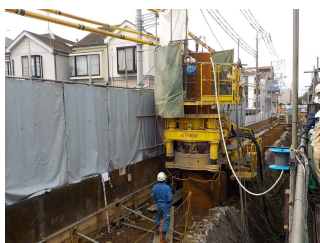
鋼管杭の打設
