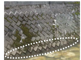
護岸の変状(ブロック隙間の拡大)
