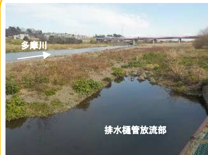
排水樋管放流部
