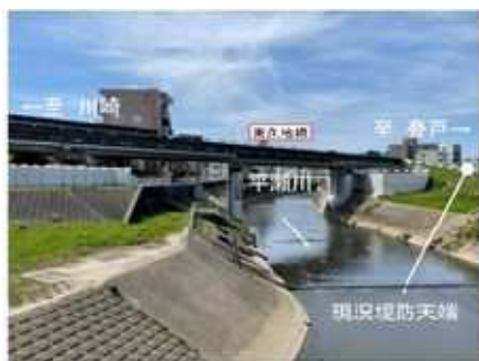
平瀬川との合流部（東久地橋付近）
