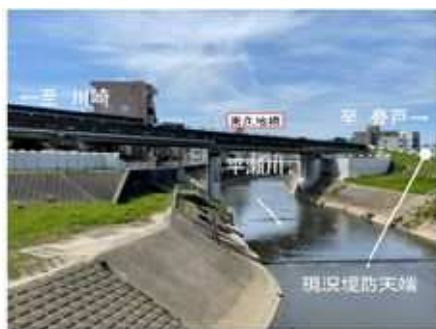
平瀬川との合流部（東久地橋付近）
